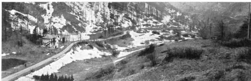
FIG. 6 - Particolare dell'alveo abbandonato 3 del Rio del Laux all'estremità inferiore del corpo B: mentre esso appare relativamente poco inciso, l'alveo attuale è profondo fino a circa 80 m.
