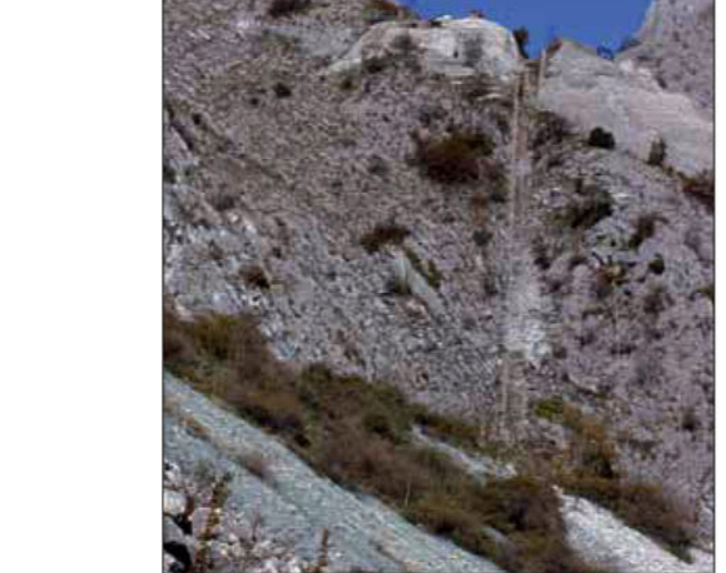
Area di cave presso Trugliano (Colonnata Basin) La collezione di marmo si sviluppa su numerosi fronti sovrapposti che hanno intaccato Cima Gioia. All'altale via d'arrampicata si innalzano sui ravaneti raggiungendo i diversi fronti di cave (30 Maggio 2003).
