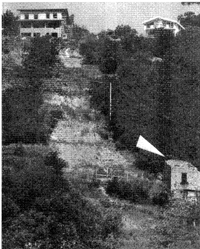
FIG. 8 - La frana di M. Pendolo a Pimonte del Gennaio 1997; la freccia indica la casa distrutta dalla frana del 1963.
