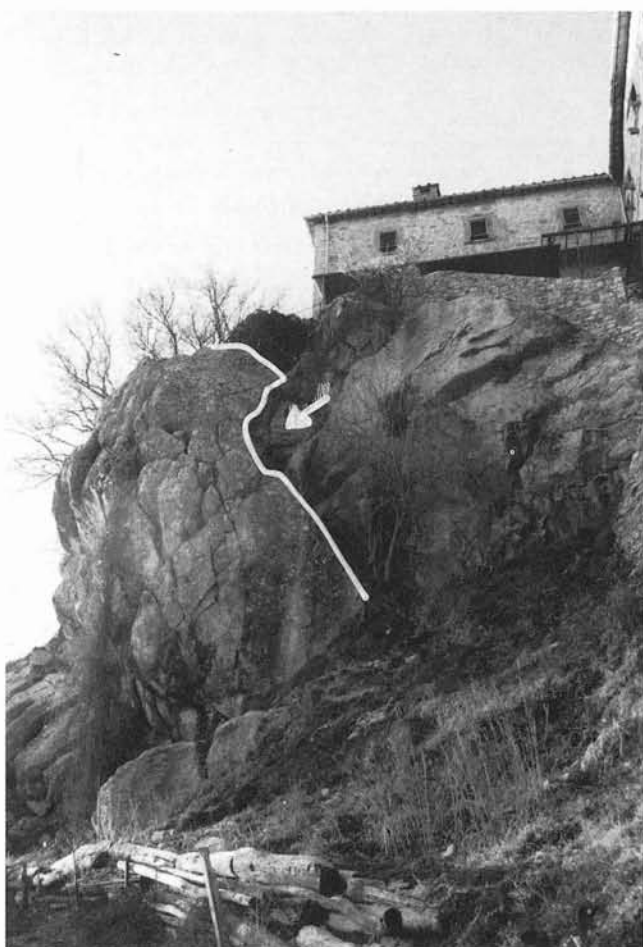
FIG. 2 - Particolare della base dell'eremo con l'ampia frattura (apertura massima di 4 m) subito a valle dell'edificio. FIG. 2 - Detail of the foundation of the hermitage with wide fracture (4 metre at most).
