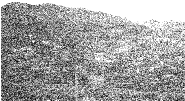
FIG. 5 - Vista del versante di S. Romano in Garfagnana; sono riconoscibili le trincee (T) e alcuni vasti movimenti di massa.
