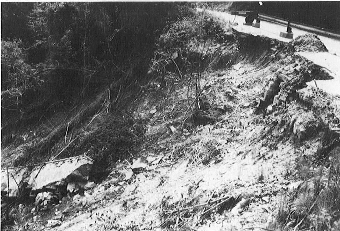
FIGG. 3-4 - Frane di modeste dimensioni interessano spesso la coltre di alterazione delle formazioni a contenuto argilloso relativamente elevato. La fig. 4 è un dettaglio della precedente e mostra gli inconvenienti creati da tali movimenti di massa alla viabilità ordinaria.
