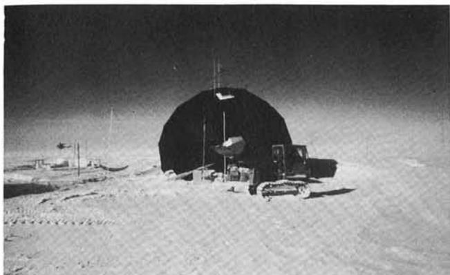
FIG. 3 - La cupola in legno che contiene la parte logistica del campo: sala radio, generatore di corrente elettrica, sala da pranzo, cucina. Per evitare il congelamento durante le soste, le parte idrauliche del caterpillar (in primo piano) e degli altri mezzi a motore sono dotate di resistenze elettriche, collegabili alla rete del campo.
