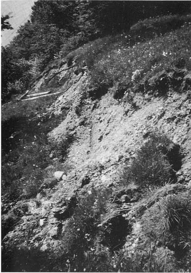
FIG. 9 - Particolare della nicchia di distacco del corpo B 10 , impostata in corrispondenza al settore inferiore del corpo B 2 di cui si osserva la costituzione ed in particolare l'abbondanza della matrice limosa-sabbiosa.
