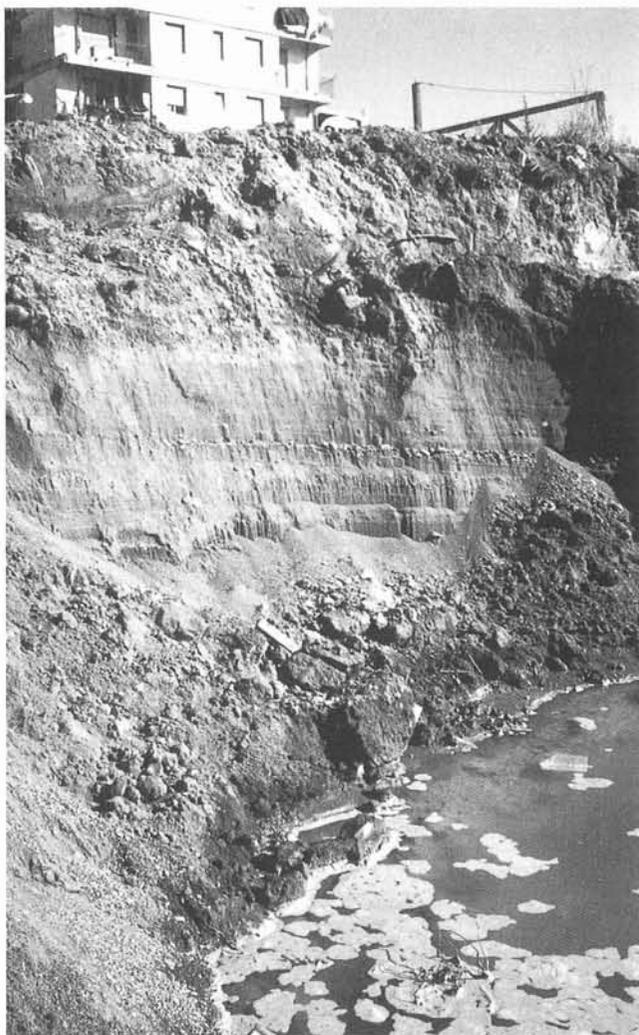
FIG. 2 - Parete di scavo, aperta a Lavagna in Corso Genova, orientata perpendicolarmente all'attuale linea di riva, che si trova 172 m più a destra della fotografia, e mostrante la sequenza sedimentaria di cui allo schema di fig. 3. Il livello dell'acqua visibile in primo piano rappresenta la superficie libera della falda freatica.
