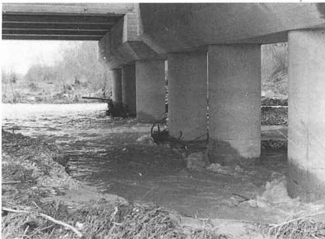
FIG. 14 - Scalzamento al piede di entità molto ridotta dei piloni di un ponte costruito agli inizi degli anni 70, sul Fiume Aso.
