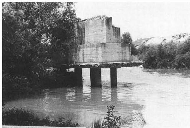
FIG. 12 - Vistoso scalzamento al piede di un manufatto costruito nel 1968 circa poco a valle di Ascoli Piceno (Tronto).
