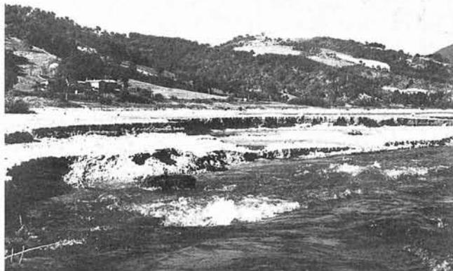
FIG. 7 - Argille, limi e sabbie, depositatesi nel periodo 1967/1985 nell'invaso artificiale di Polverina (Chienti), sovrastanti alle alluvioni ghiaiose del 3° ordine.
