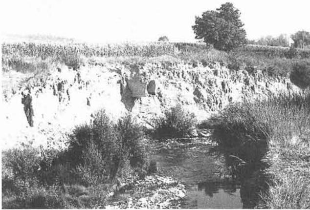
FIG. 13 - Rete fognante troncata per effetto dell'erosione laterale e dell'approfondimento dell'alveo fluviale del Chienti (poco a valle di Tolentino).
