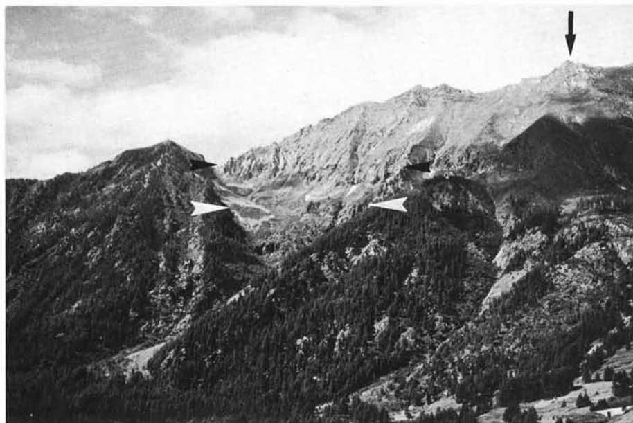
Fig. 11. - Aspetto del versante orientale del M. Zerbion (indicato dalla freccia verticale): si osserva la nicchia di distacco principale del corpo A, corrispondente alla cresta spartiacque, e le due nicchie di distacco, a quota inferiore, indicate dalle frecce orizzontali; al di sotto di queste è riconoscibile l'esteso alveo di frana.
