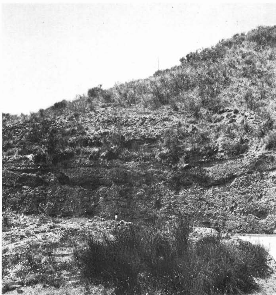
FIG. 10 - Canale a base piatta con riempimento di conglomerati a stratificazione obliqua; sezione Episcopia-Fardella.
