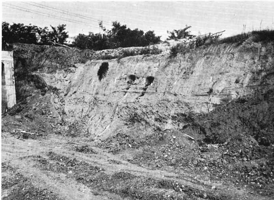
FIG. 2 - Sponda destra del canale scolmatore del Torrente Ossona all'altezza del sottopasso con la linea ferroviaria Milano-Genova (di cui si intravede una spalla dell'imboccatura sul lato sinistro della fotografia). La palina, visibile a destra nella fotografia, è posta all'altezza del limite tra alluvioni ciottolose di base e soprastanti depositi sabbiosi contenenti livelli con involuzioni, il cui particolare è riprodotto in fig. 3.
